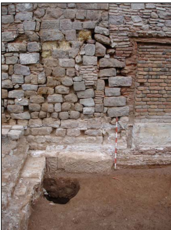
Vista des de l'oest dels pilars de l'aqüeducte (en sentit nord – sud) una vegada descoberts els seus basaments i fonamentacions
