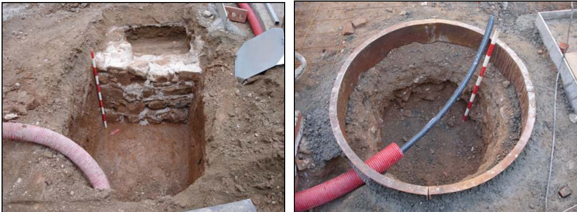
Vista des del nord-oest del Sondeig 700 amb el mur u.e. 701 i vista des del nord del Sondeig 800.
