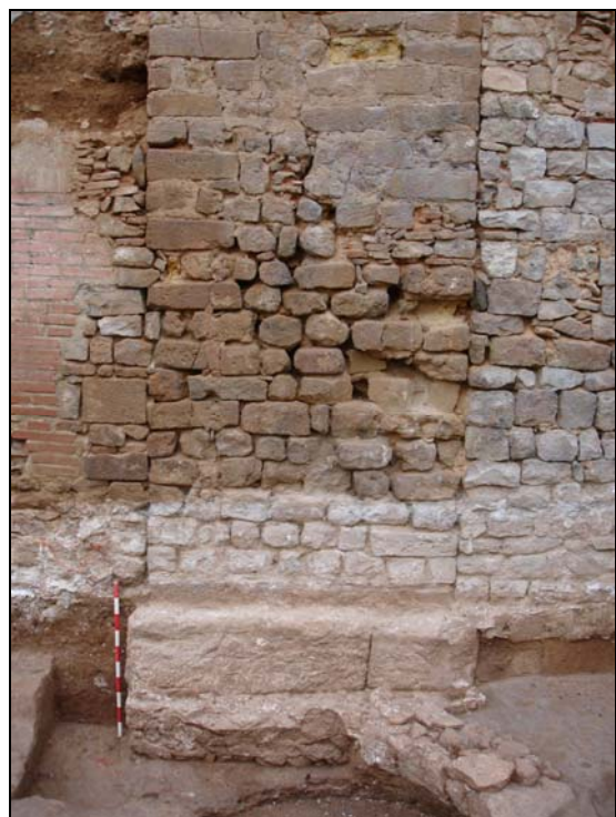
Vista des de l'oest dels pilars de l'aqüeducte (en sentit nord – sud) una vegada descoberts els seus basaments i fonamentacions
