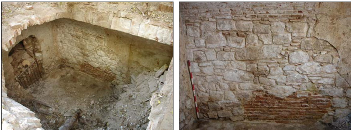
Vista general des del nord del soterrani 1 i detall de la cala parietal realitzada al seu mur oest u.e. 305
